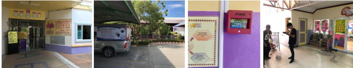
ติดตั้งระบบสัญญาณเตือนไฟไหม้ โรงเรียนเมทนีดล
